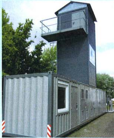
Pilotanlage in Altenrhein
